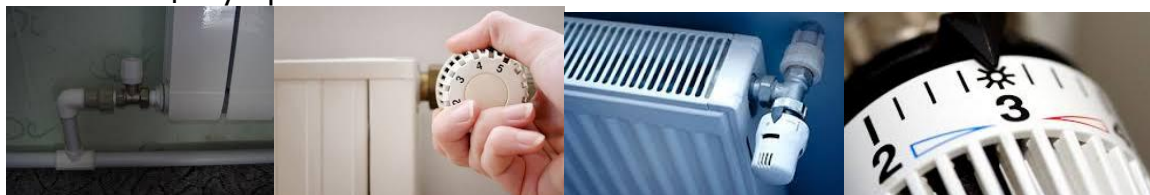
Рис. 5. Терморегуляторы и отключающие устройства нагревательных приборов.
