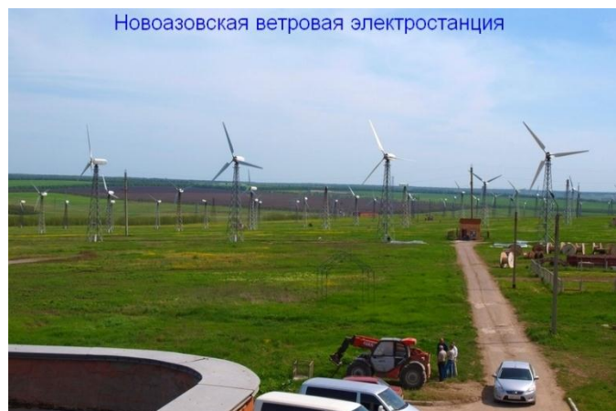
Рисунок 3 –Ветровая электростанция в Новоазовском районе ДНР
